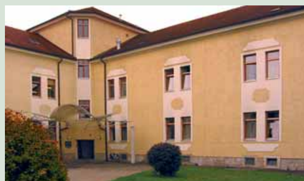
Die Stationen PS23 und PS24 sind im C-Gebäude (Eckeingang) untergebracht.
