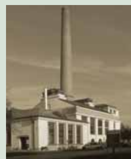
Das Kesselhaus entstand 1927/28 im Zuge von Modernisierungsumbauten.
