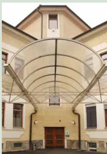
Die Stationen PS13 und PS15 sind im B-Gebäude unter- gebracht (Eckeingang)
