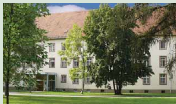
Die Stationen PS21 und PS22 befinden sich im A-Gebäude
